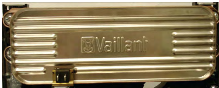
Вторичный теплообменник с датчиком NTC
