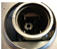
Встроенная трубка Пито
